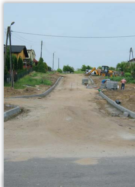
BUDOWA ULICY MICKIEWICZA - TRWAJĄ PRACE ZWIĄZANE Z WBUDOWYWIANIEM KRAWĘŻNIKÓW.
