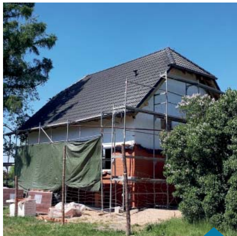
Budowa garażu OSP w Łopuchowie.
