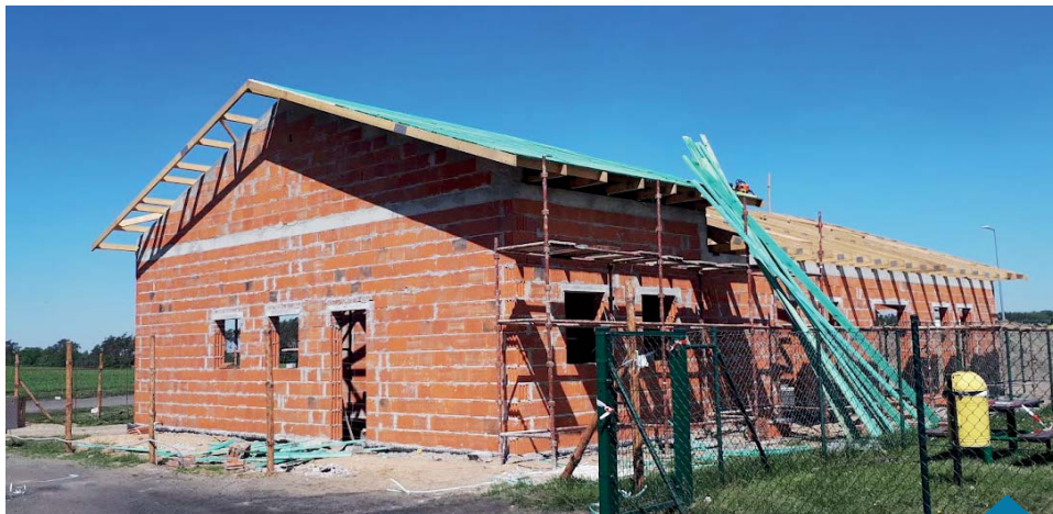
budowa świetlicy wiejskiej w Nieszawie.
