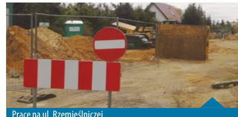
Prace na ul. Rzemieślniczej.
