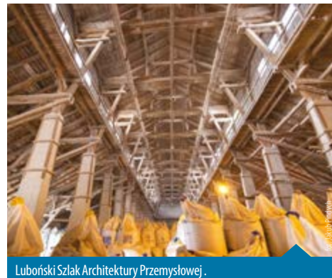
Luboński Szlak Architektury Przemysłowej.
