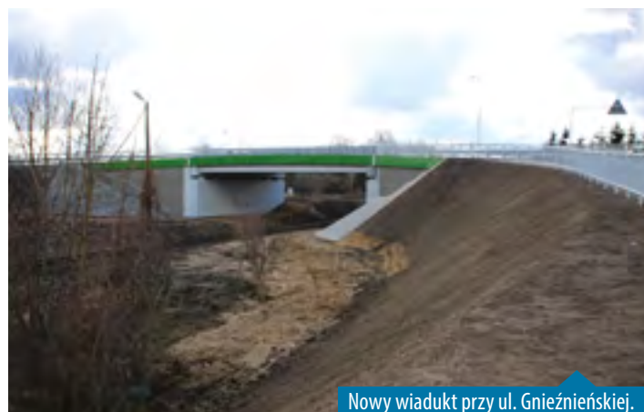
Nowy wiadukt przy ul. Gnieźnińskiej.
