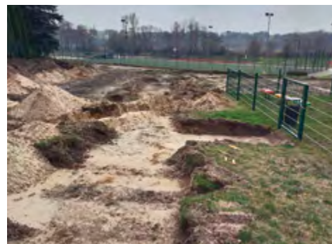
Modernizacja stadionu miejskiego, trwają prace.
