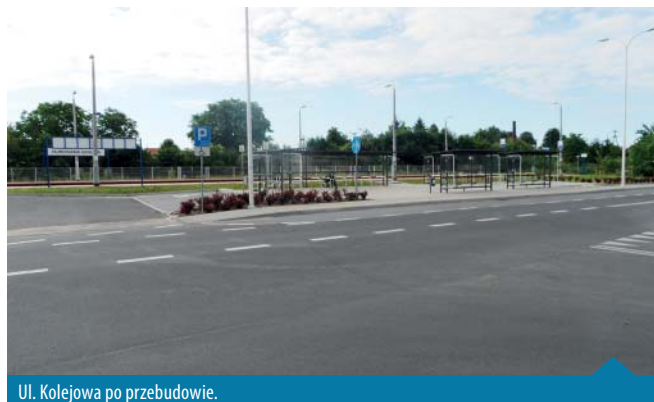
Ul. Kolejowa po przebudowie.
