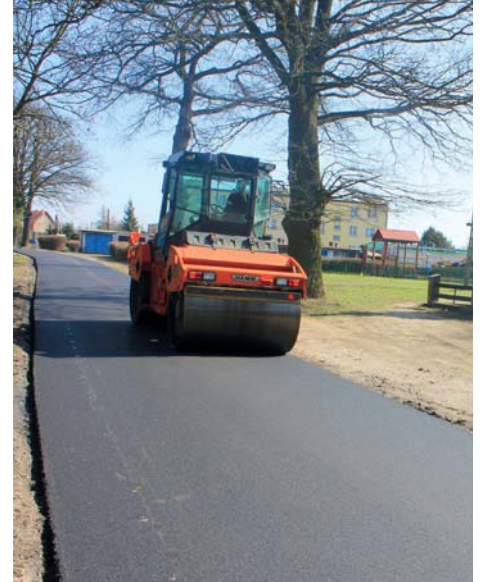
Rekonstrukcja dróg w Łopuchowie.
